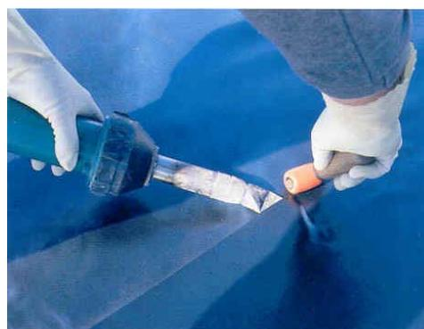
A la vez que se va pasando el soplador de aire caliente, se presiona la misma zona de forma uniforme con un rodillo de goma rígido.
